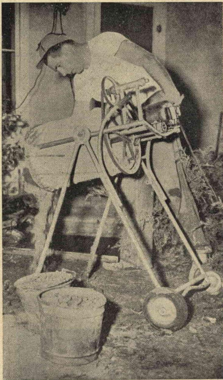
Questo è il terzo progetto di betoniera che presentiamo ai nostri lettori. C'induce a farlo la semplicità della sua costruzione, imperniata su di un bidone cilindrico
